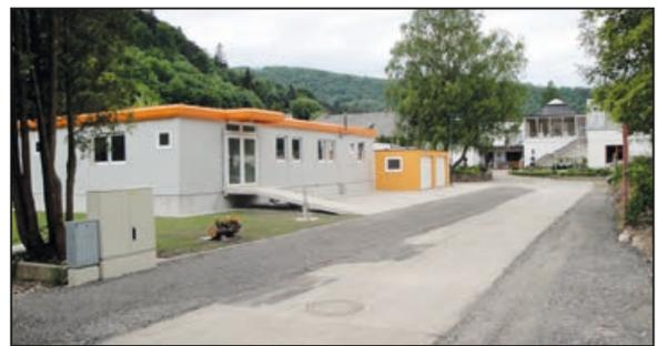
In der **Gartengasse** (Bild oben) wurden die Bankette mit Asphaltrecycling Material befestigt. Nach der Fertigstellung der Feuerwehr und des Pfarrzentrums wird diese provisorische Maßnahme durch eine Asphaltfahrbahn ersetzt werden.
