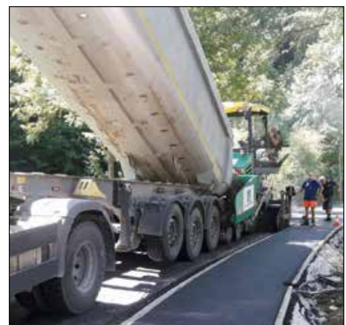
Sanierung Siedlung am Brand
