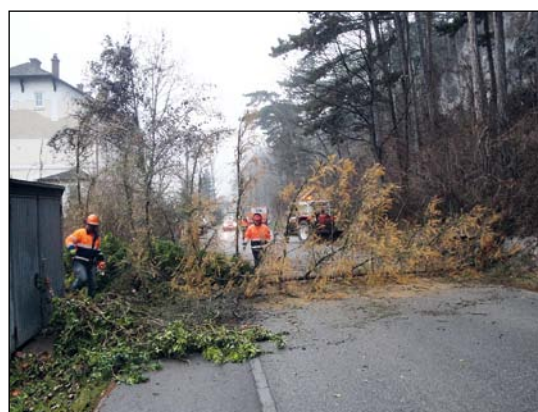
Die kurzfristig gesperrte Further Straße
