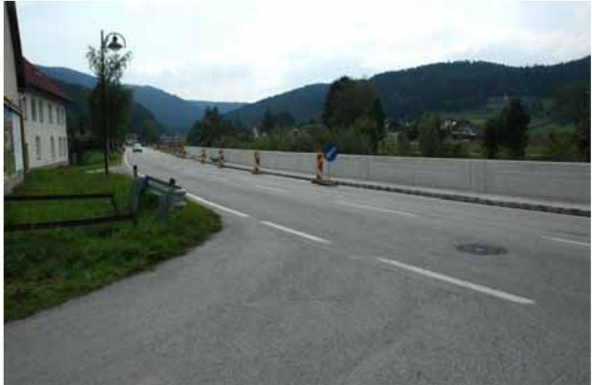
Weiter linksufrig, im Bereich der Firma Akyüz wurde an der Böschungsoberkante eine etwa 200 m lange Hochwasserschutzmauer hergestellt.
